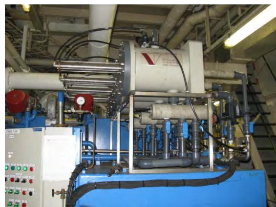
Biologische afvalwaterzuivering aan boord van pijpenlegger Lorelay (HMSA)
